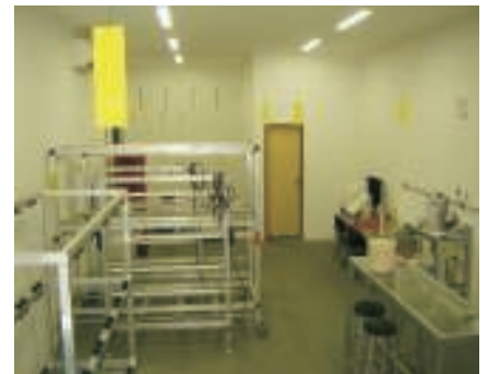
Filtro em funcionamento
